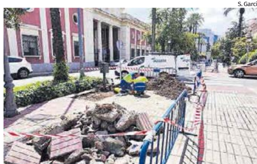
Trabajadores de Parques y Jardines abren zanjas en otro tramo.
